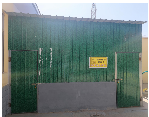
医疗废物暂存间
